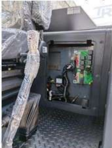
Централизованный блок предохранителей
